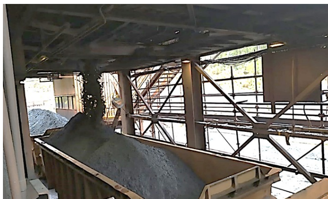
Fig. 2. Vagão sob silo para carregamento de minério.
