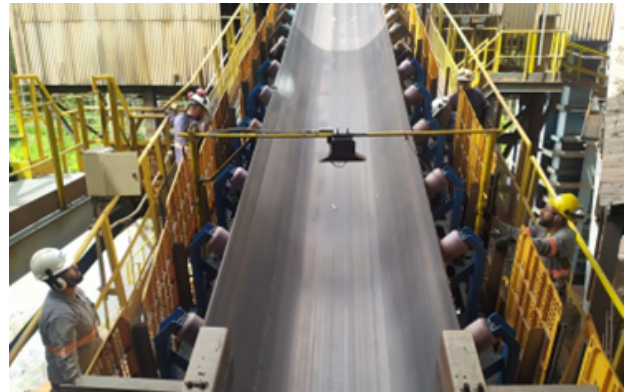
Fig. 6. Montagens e ajustes finais do sensor LiDAR sobre o transportador.
