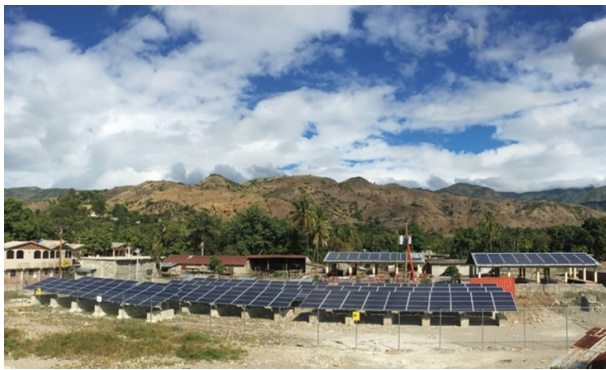
Fig. 7 Les Anglais solar microgrid in Haiti [36] .
