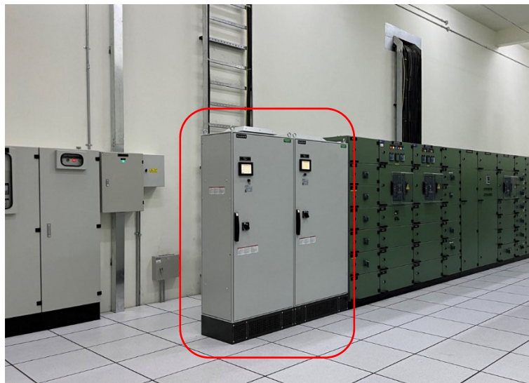
FIGURE 6. Actual set up SAPF.
